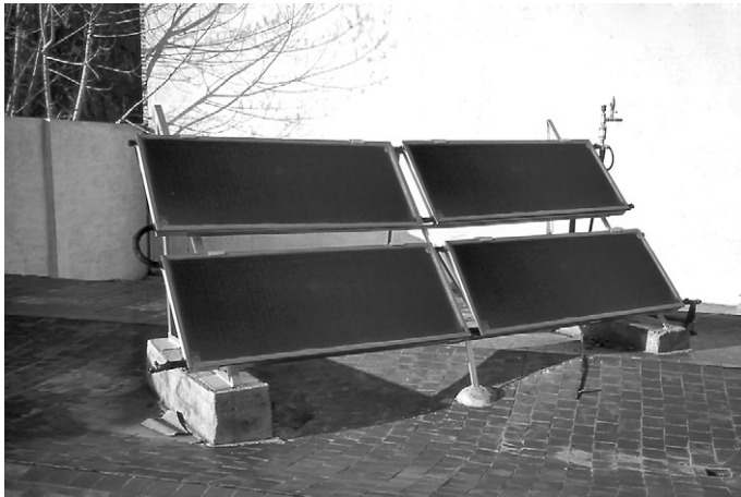
Fig. 4.2. Instalación casera de cuatro captadores planos, montados en la terraza de una vivienda unifamiliar.
