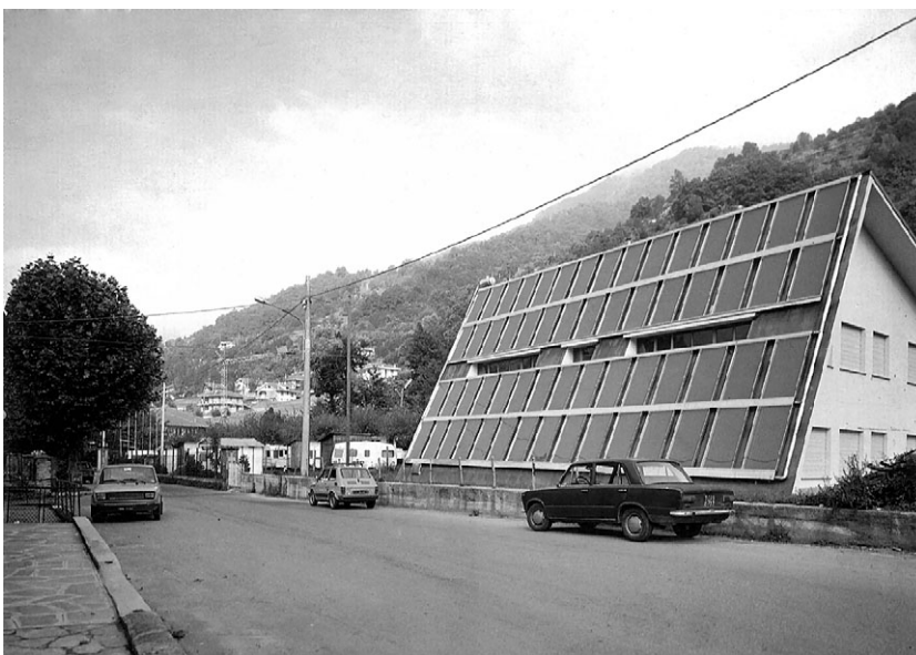
Fig. 3.34. Los captadores planos se adaptan bastante bien a las cubiertas inclinadas de muchas construcciones en zonas de montaña, e incluso sirven de protección y aislante térmico del edificio.
