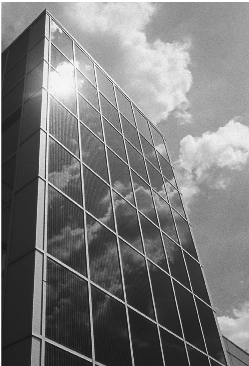
Fig. 5.30. La «arquitectura fotovoltaica» está cobrando cada vez más importancia a la hora de diseñar nuevos edificios.
