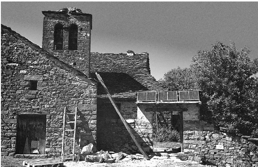
Fig. 5.14. La alta tecnología empleada en la fabricación de los módulos fotovoltaicos de la fotografía contrasta con la vieja construcción rural en la que han sido instalados.
