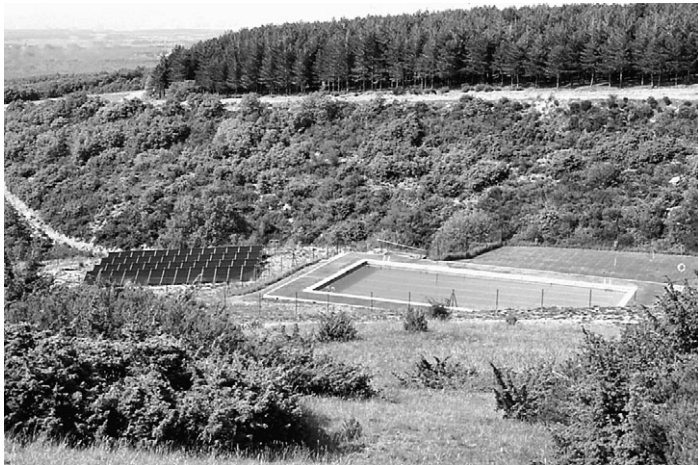
Fig. 3.39. En esta fotografía puede compararse la superficie total que ocupan los captadores necesarios para mantener templada el agua de una piscina al aire libre, con la propia área de ésta.
