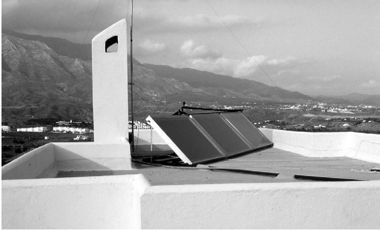
Fig. 6.1. En climas benignos bastan tres o cuatro captadores de tamaño medio para producir toda el agua caliente que se necesita en una vivienda unifamiliar.
