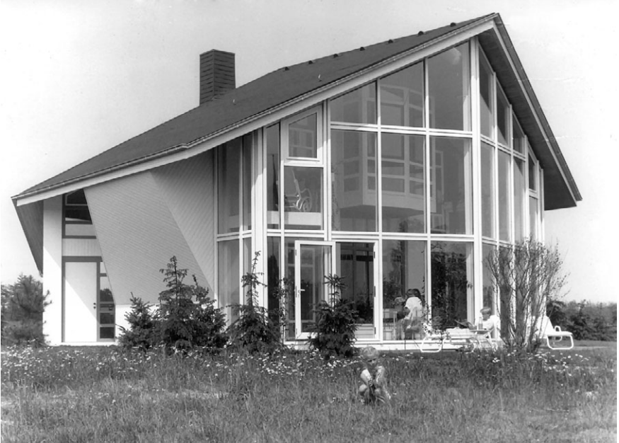
Fig. 1.1. El aprovechamiento pasivo de la energía solar, mediante dobles fachadas acristaladas y correctamente orientadas, es una solución arquitectónica que debería ser utilizada más ampliamente. La vivienda de la fotografía logra un excelente rendimiento energético mediante elementos puramente constructivos: materiales aislantes y grandes superficies translúcidas.
