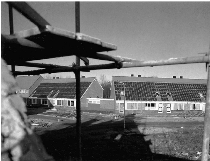
Fig. 5.16. Viviendas con plena electrificación mediante módulos fotovoltaicos. Obsérvese que éstos ocupan casi toda la superficie disponible en el tejado.
