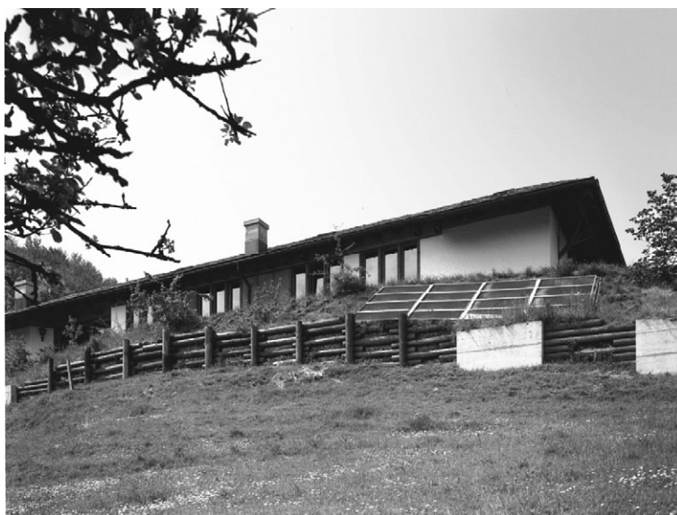
Fig. 3.37. Conjunto de captadores planos instalados en el suelo, que proveen de agua caliente a una pequeña industria rural.
