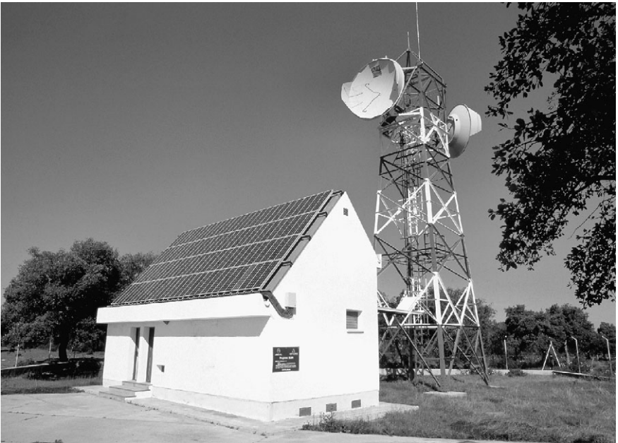
Fig. 5.25. Alimentación fotovoltaica de un sistema de telecomunicaciones.
