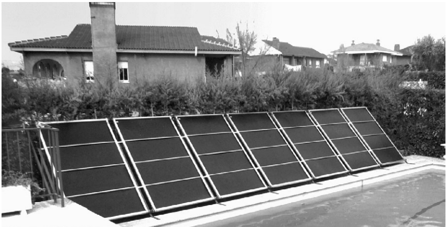
Fig. 3.31. Captadores solares de polipropileno negro. (Cortesía de Europea de Técnicas Ambientales, S.L.).
