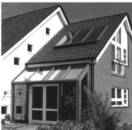
Fig. 3.35. Diversas disposiciones de captadores térmicos instalados en viviendas unifamiliares.
