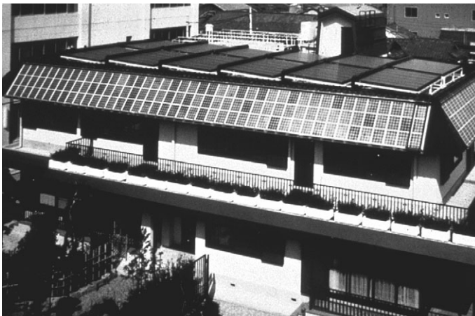
Fig. 3.33. Una vivienda alimentada con energía solar. Los captadores de la parte superior, casi horizontales, proporcionan agua caliente y calefacción, y los módulos fotovoltaicos (inclinados), electricidad.
