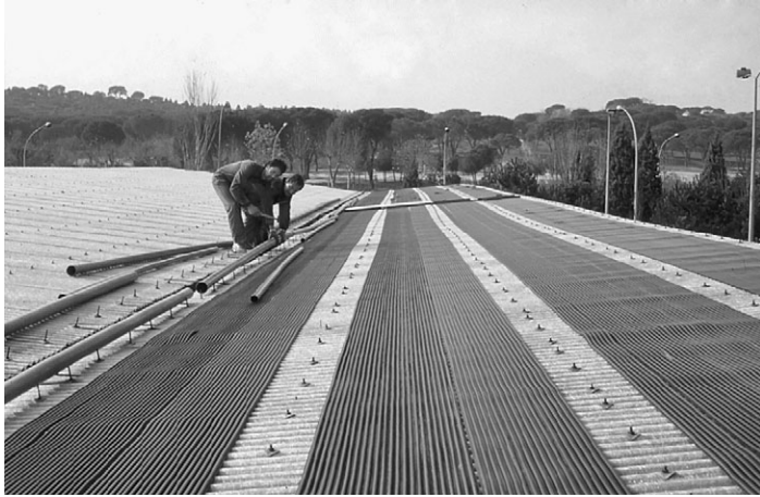
Fig. 3.38. Proceso del montaje de captadores flexibles, que se presentan en rollos de gran longitud y son más económicos que los captadores con cubierta.
