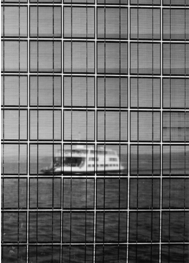
Fig. 5.22. Los nuevos módulos fotovoltaicos semi-transparentes pueden sustituir en determinados casos a los vidrios de las ventanas.
