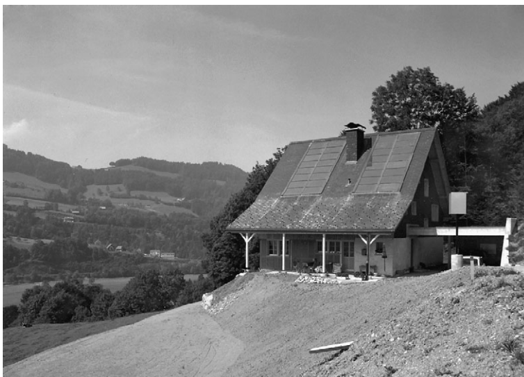
Fig. 3.29. El mejor momento de acometer el montaje de una instalación solar es durante la fase final de la construcción de la vivienda.
