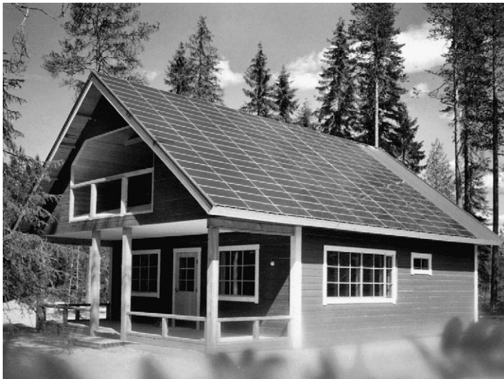
Fig. 5.29. Cabaña de campo plenamente electrificada mediante módulos fotovoltaicos.
