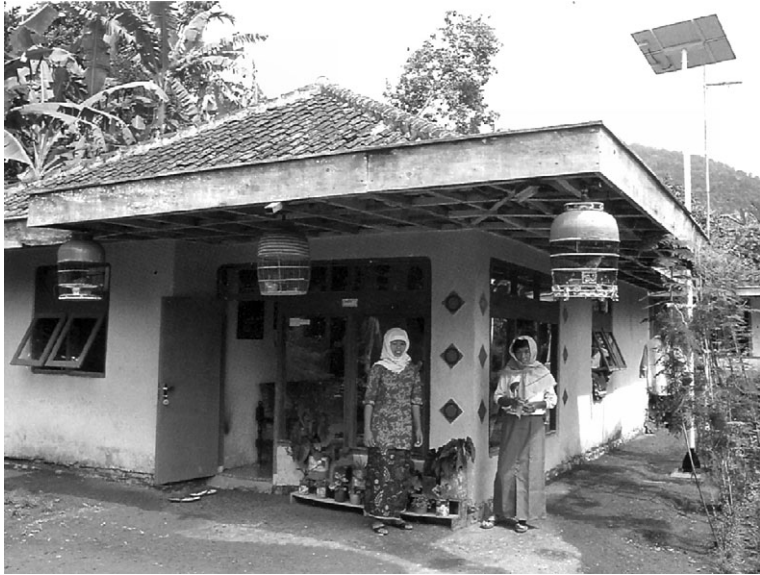
Fig. 3.44. La energía fotovoltaica constituye la solución idónea para la electrificación básica de las viviendas en países poco desarrollados.
