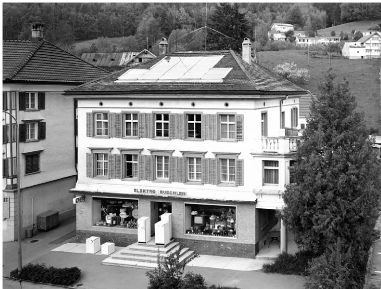
Fig. 3.36. Instalación que suministra agua caliente a un pequeño establecimiento comercial y a dos plantas situadas en el mismo edificio.
