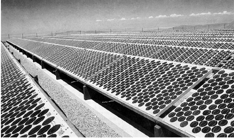
Fig. 3.43. Planta fotovoltaica capaz de generar una gran potencia. Los módulos son de células redondas, cada vez menos utilizadas.
