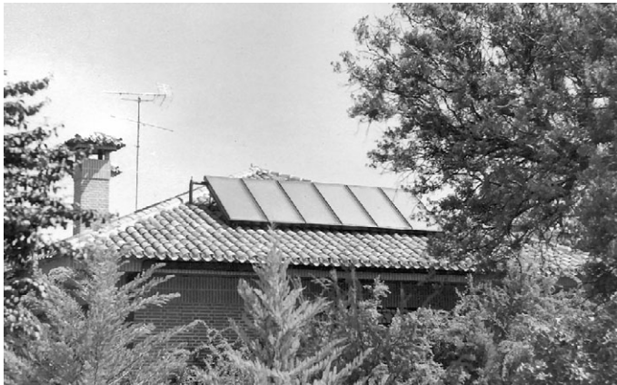
Fig. 3.9. Por lo general, media docena de captadores de unos 2 m 2 cada uno son suficientes para proveer de abundante agua caliente a una vivienda unifamiliar de tamaño grande.
