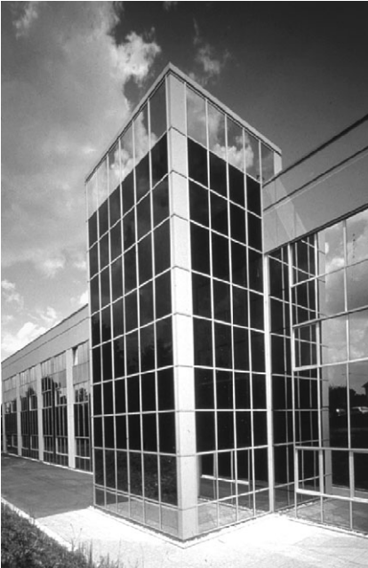
Fig. 6.4. Dos posibilidades, de fuerte contraste, de una misma aplicación; arriba: electrificación de una vivienda rural aislada; abajo: moderno edificio fotovoltaico conectado a red.
