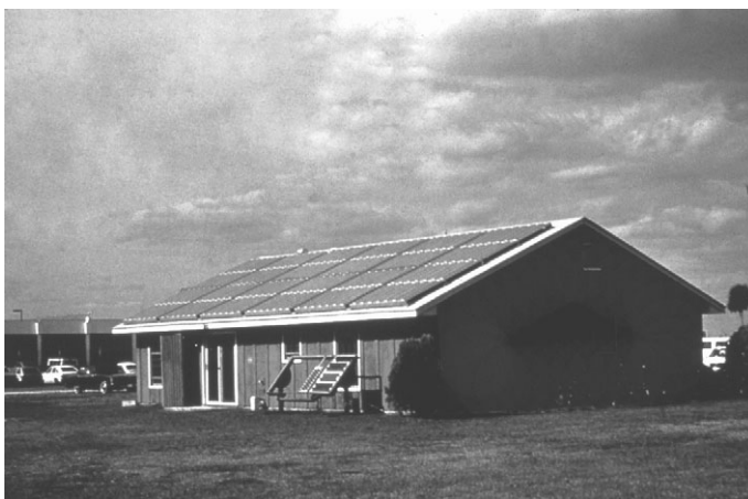
Fig. 5.17. Electrificación total mediante módulos fotovoltaicos. Esta opción, que será habitual en una o dos décadas, resulta todavía demasiado cara para una economía media. El sistema que se ve en la fotografía proporciona una media de casi 8000 kW·h al año, suficiente para satisfacer el consumo total de una típica familia de cualquier país desarrollado.
