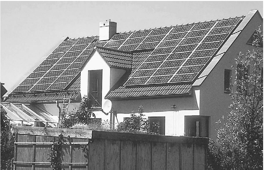
Fig. 3.21. Integración de la energía solar en una vivienda rural.
