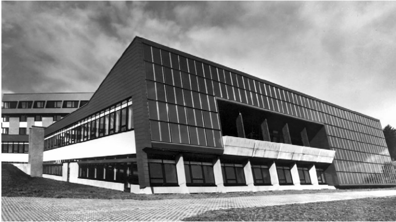
Fig. 3.8. Instalación térmica con un total de 252 captadores y 20 000 litros de acumulación.
