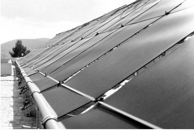
Fig. 4.8. Captadores flexibles, una vez instalados.
