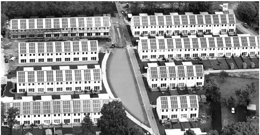
Fig. 6.3. Viviendas unifamiliares fotovoltaicas conectadas a la red, una posibilidad que puede transformar radicalmente el concepto tradicional de producción y distribución de la electricidad.
