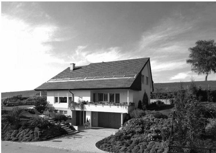
Fig. 3.28. Los captadores solares térmicos, si se disponen de forma conveniente sobre los tejados, no resultan de ningún modo antiestéticos, como puede comprobarse en la foto.
